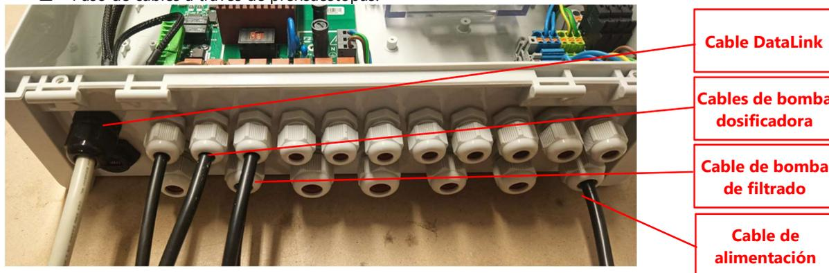
Figura 6 – Paso de cables a través de prensaestopas.
